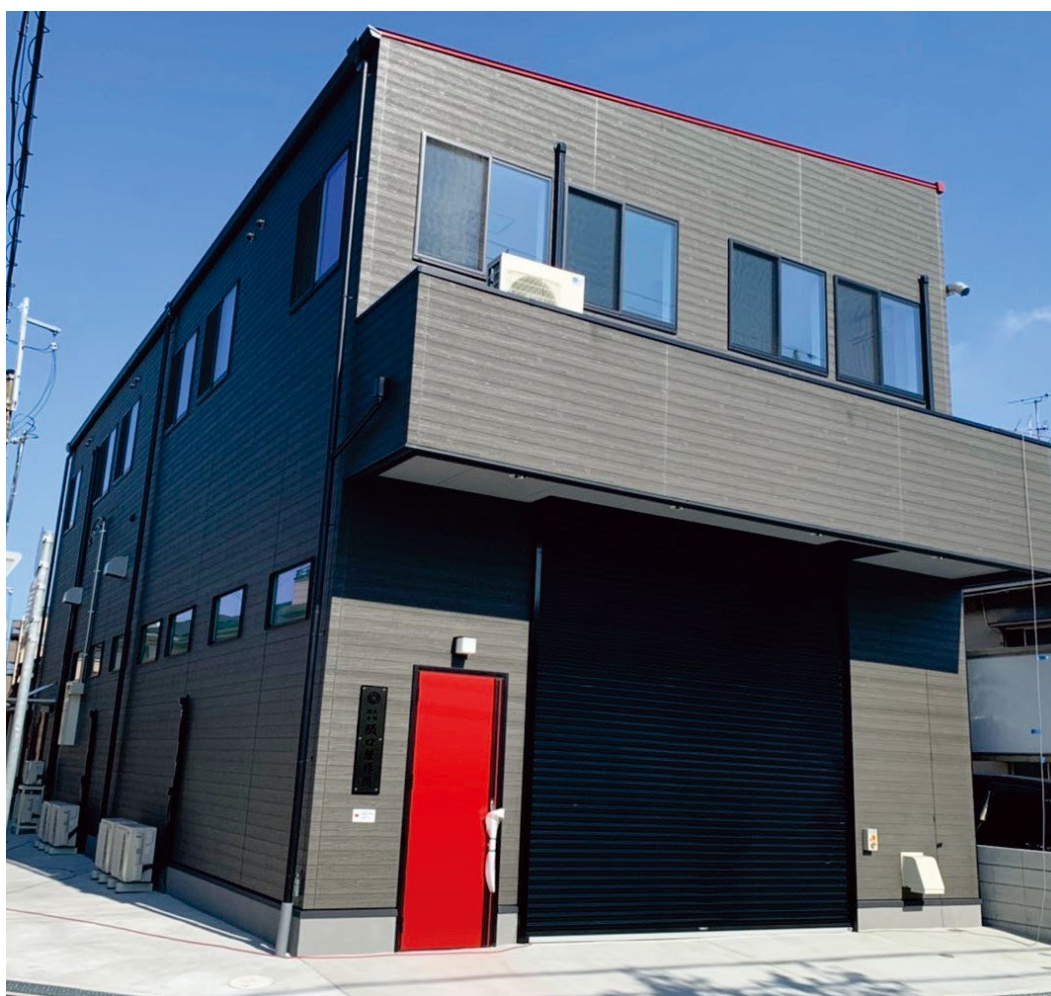
上記写真:新工場(2021年9月完成)
